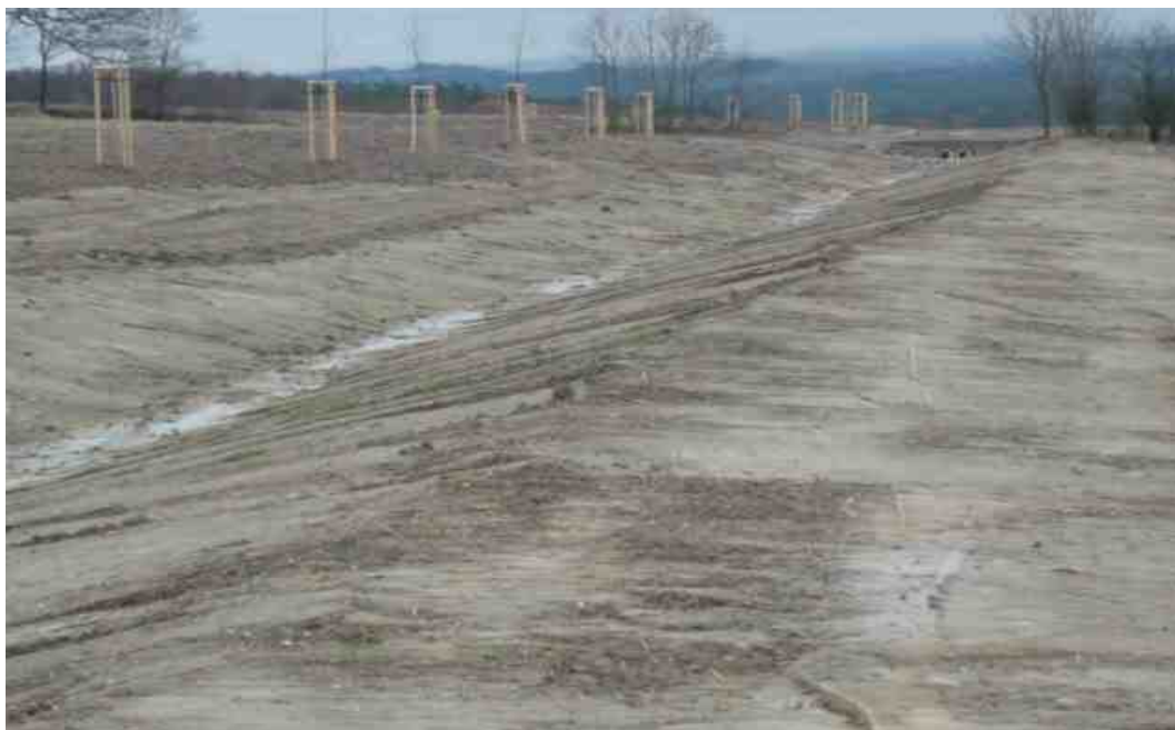
Zasakovací průleh uprostřed svažitého půdního bloku jako ochrana proti bleskovým povodním, které ohrožují zastavěnou část obce, zvyšuje retenci vody v krajině, rozděluje nevhodnou velikost bloku orné půdy a nepřerušenou délku svahu způsobující erozi půdy. (Hromnice Plzeň sever 2014)
