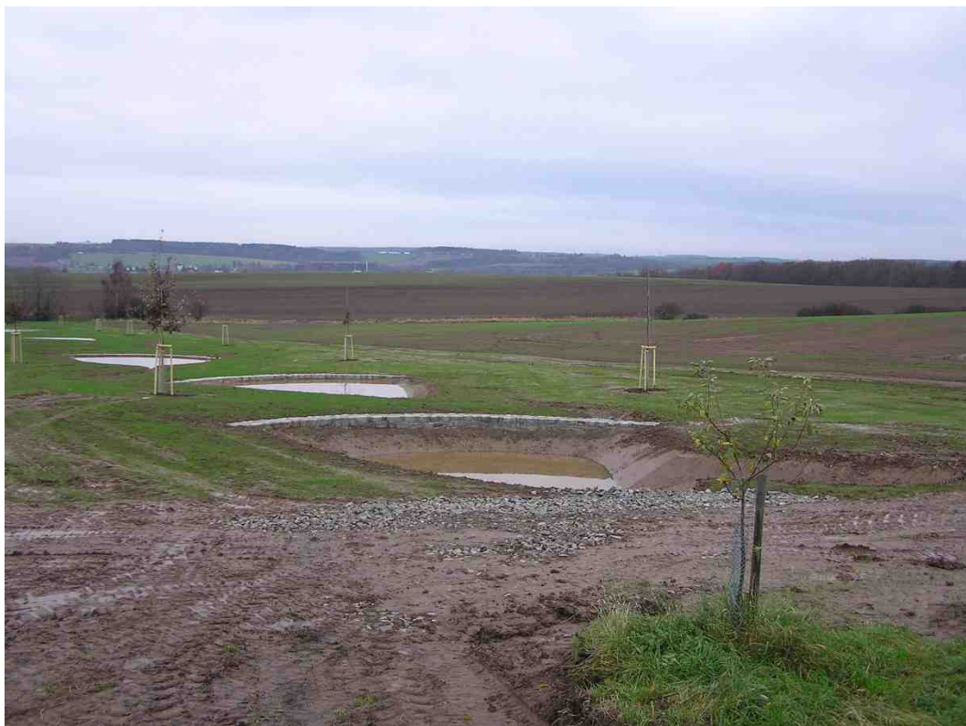
Soustava šesti vsakovacích jam na revitalizovaném trubním odpadu z výše položeného půdního bloku orné půdy, který je odvodněn systematickou drenáží ( Hněvnice, Plzeň-sever, 2015)
